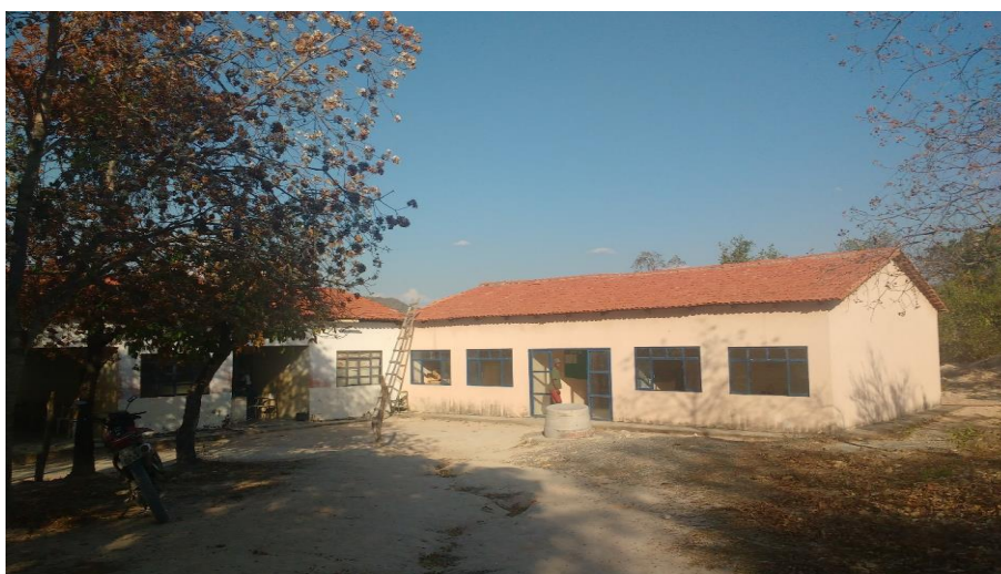
Figura 3. Prédio da Escola Estadual Vão de Almas. Autora: Débora Haifa da Silva Costa 2018
